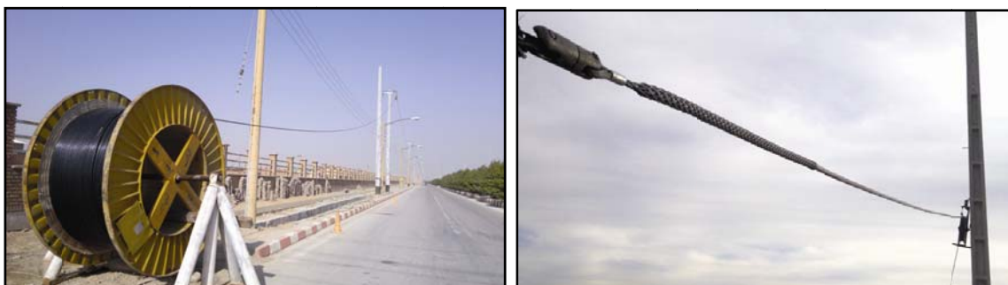
شکل ۲۱ - باز کردن هادی روکش‌دار
