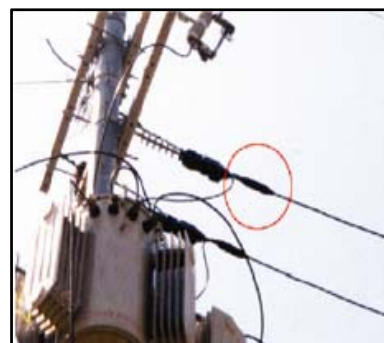
الف- بر روی شاخک تخلیه قوس
