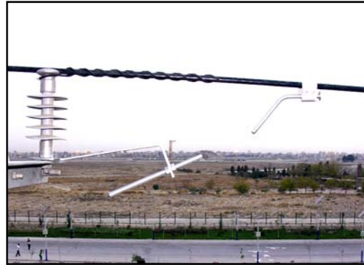
الف- در آرایش عبوری با مقره سوزنی
