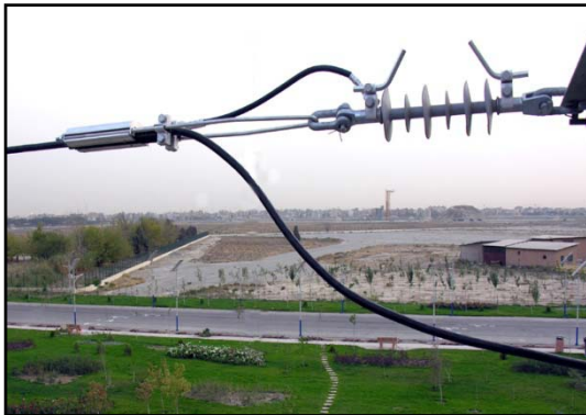
ب- در آرایش پایه زاویه ای و کششی
