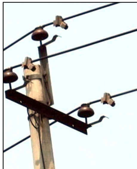
الف- بر روی شاخک تخلیه قوس
