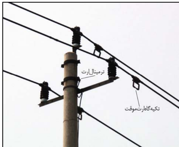
شکل ۱۱ - تکیه گاه های اتصال ارت موقت ( رکاب دارای کلمپ دو طرف)
